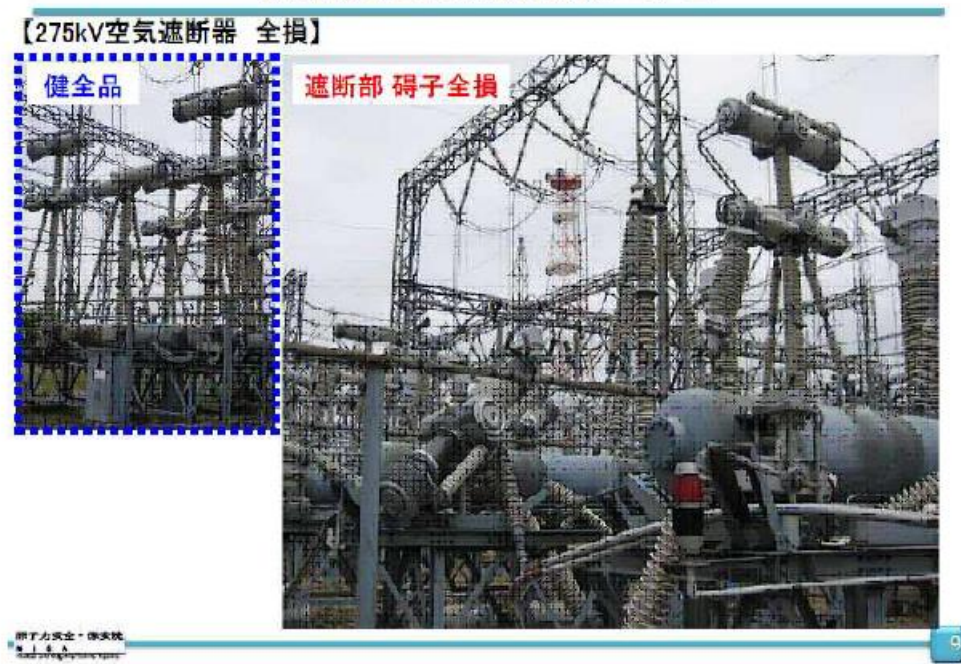
図1 「東京電力株式会社福島第一原子力発電所事故の技術的知見について中間とりまとめ参考資料集・原子力発電所の外部電源に係る状況について」（原子力安全・保安院平成23年10月24日）より福島第一原発変電設備の被害状況
