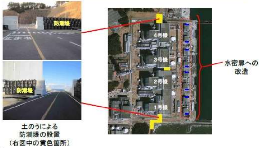
図 16 土嚢による防潮堤の設置
