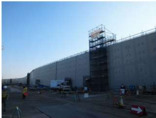
図 14 海拔 22m の防波壁（総延長約 1.6km）を設置。 （中部電力ウェブサイト）
