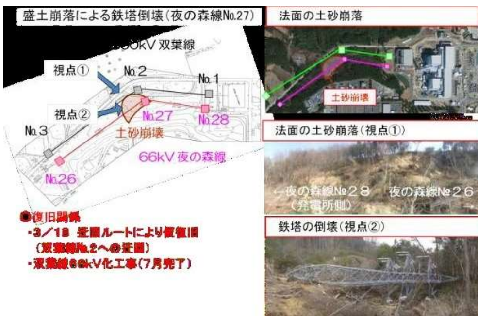
図 3 盛土崩落による鉄塔崩壊 夜の森線 「東京電力株式会社福島第一原子力発電所事故の技術的知見について 図表集」(原子力安全・保安院 平成24年2月16日)より
