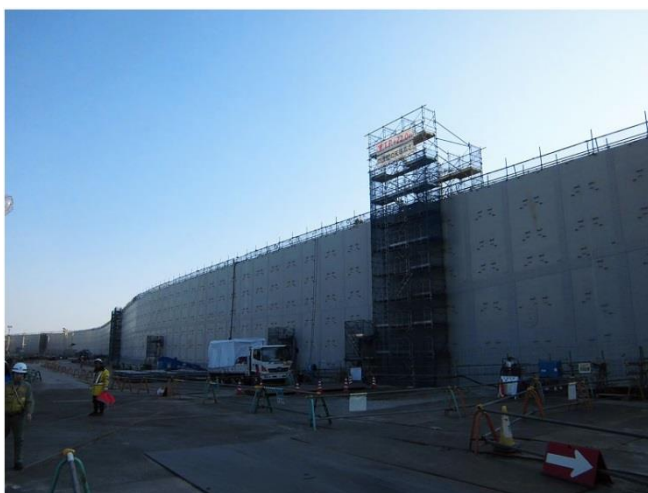
図12 海拔22mの防波壁（総延長約1.6km）を設置。（中部電力ウェブサイト）
