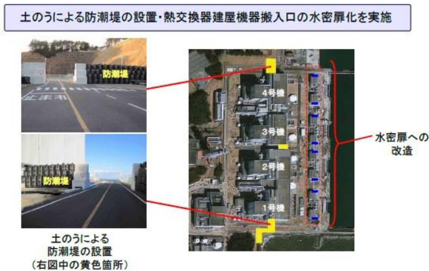
図14 土嚢による防潮堤の設置
