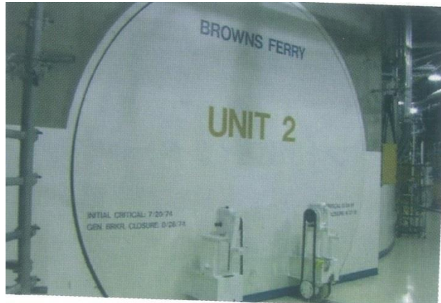
図 17 非常用発電機室の防水扉（ブラウズフェリー原発）
