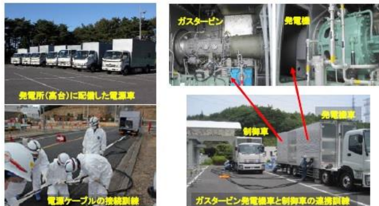
図 4 高所電源設置
