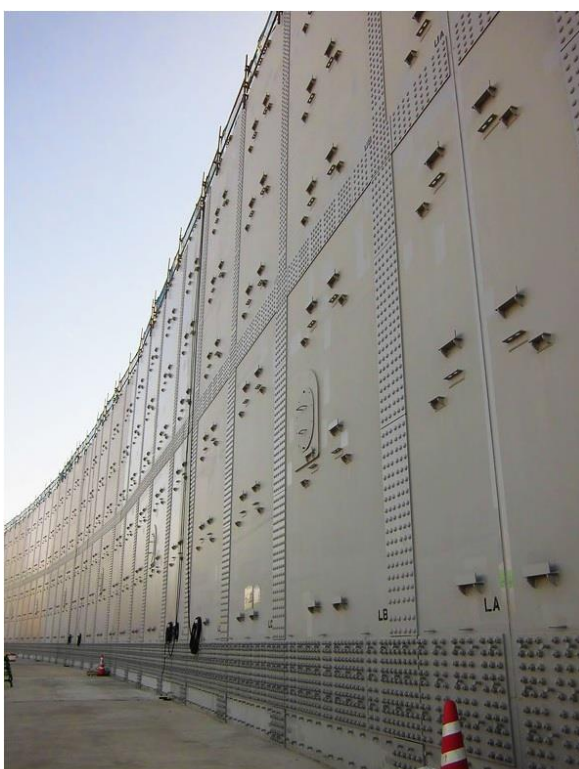
図13 海拔22mの防波壁（総延長約1.6km）を設置。（中部電力ウェブサイト）
