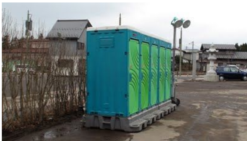
避難所付近には仮設トイレも設置されていました
