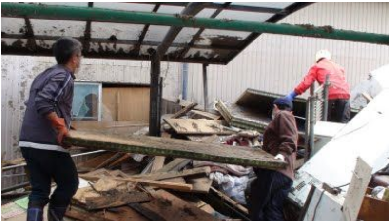
(写真 14) 住宅内の瓦礫の撤去作業中です。
