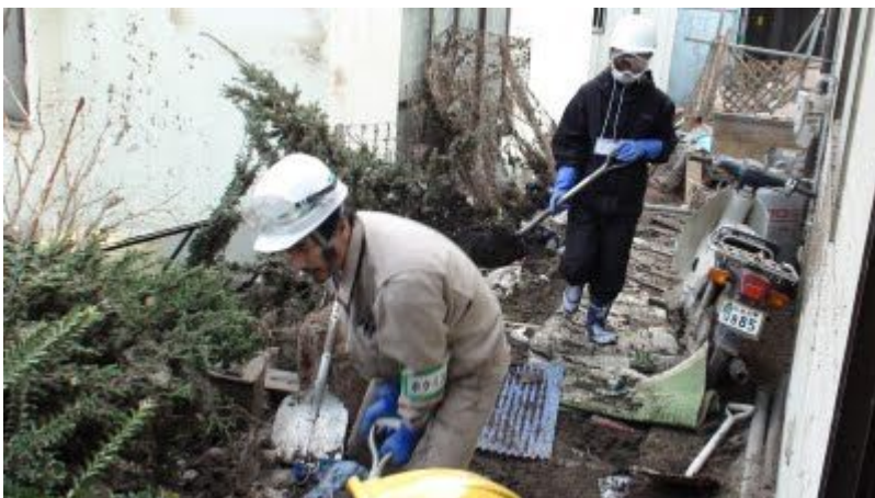
(写真 15) 住宅内の泥の撤去作業中です。
