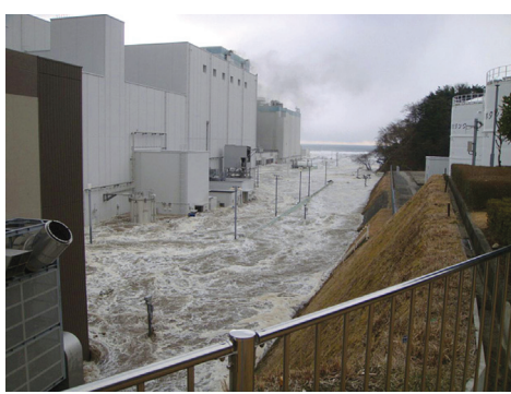
福島第二1号機の原子炉建屋の南側構内道路を、正面の海から遡上する巨大津波。道路から2〜3mが水没した。(東京電力提供)
