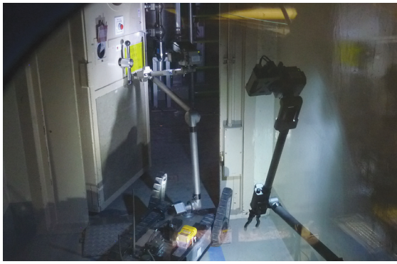
3号機原子炉建屋の二重扉の内側を開ける遠隔操作ロボット(十七日、東京電力提供)。
