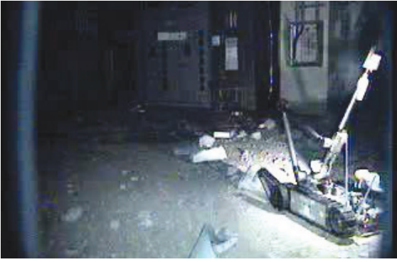
1号機の原子炉建屋一階部分を進む遠隔操作ロボット(十七日、東京電力提供)。
