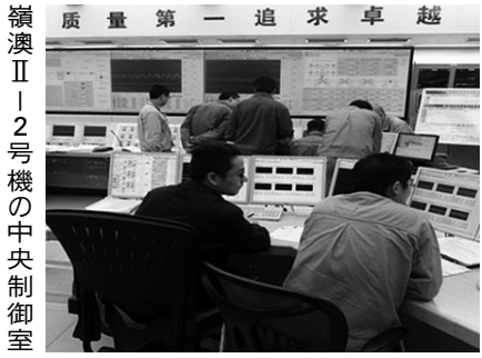
嶺澳II-2号機の中央制御室
