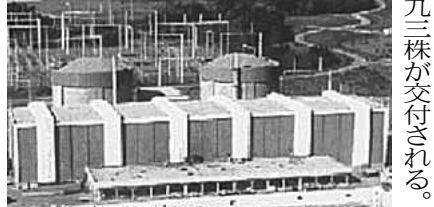
プシエール原発の建設現場
