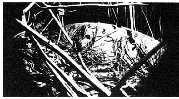
チェルノブイリ原発4号機事故の炉心部の写真。全燃料が破壊されたか溶融して、吹き飛んだが原子炉下部に落下した。
