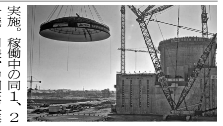
格納容器・丸屋根の吊り込み作業は六日に行われたもので、作業は中原...
