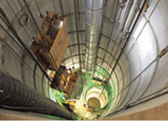
東立坑を上から見た写真。左にぶら下がっている箱が八人乗りのエレベーター。
