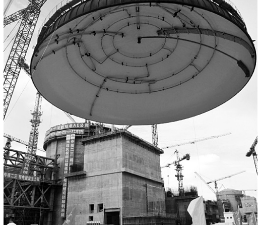
陽江3号機のドーム型屋根吊り込み作業
