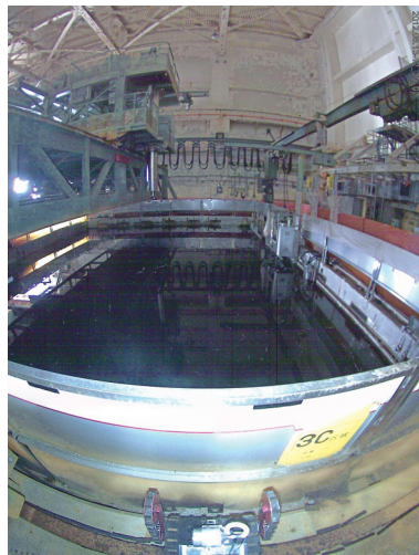
同発電所2号機建屋5F使用済み燃料プール
