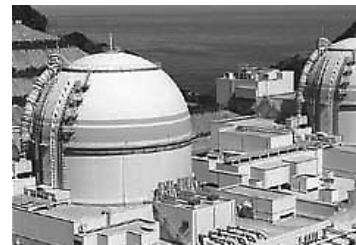
関西電力の大飯発電所。右が先に発電開始した3号機、左が今回フル発電した4号機。
