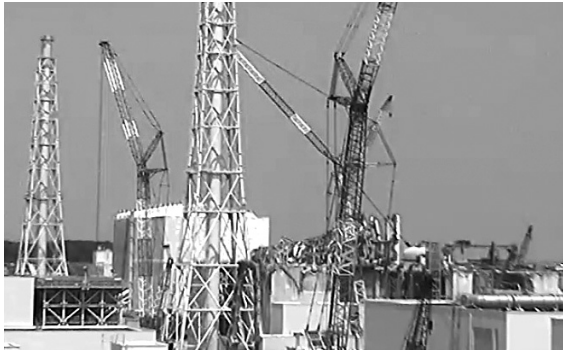
〈ふくいちライブカメラの映像〉右側の手前から4号機、左へ瓦礫のある3号機、原子炉建屋が残っている2号機、その後ろが原子炉建屋カバーの工事が終了している1号機。
