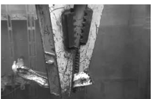
福島第一3号機で進められるがれき撤去作業の状況
