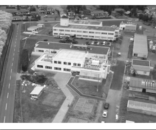
放射性物質の移行低減に関する技術開発を行う「放射性物質分析棟」を、福島市内に開設した(写真)。
