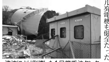
津波により倒壊した1号機重油タンク
