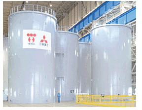
三菱重工が発表した。同発電所向け汚染水貯蔵タンクとして初の工場完成型タンクで、5月までに10基を出荷する予定だ。
